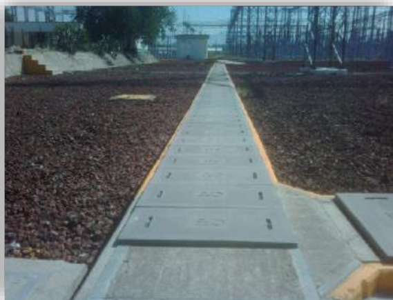
S.E. CFE - TAPAS PARA TRINCHERA
