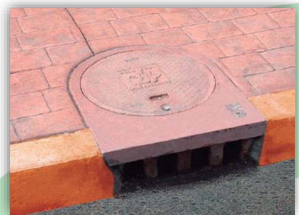
CDMX - COLADERA DE BANQUETA
